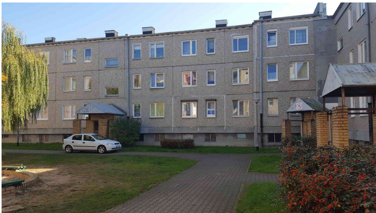
Fot. 1 Elewacja północno – zachodnia.
