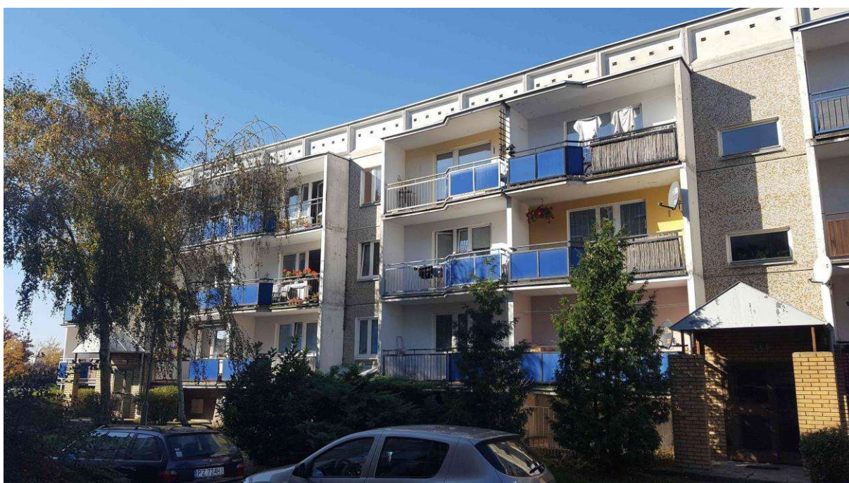
Fot. 2 Elewacja południowo - wschodnia
